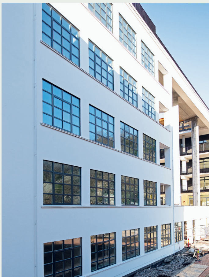
Fasade mot sør på nybygget.
