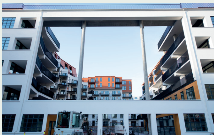
I forkant av bygget står det en 20 meter høy og 20 meter bred portal.
