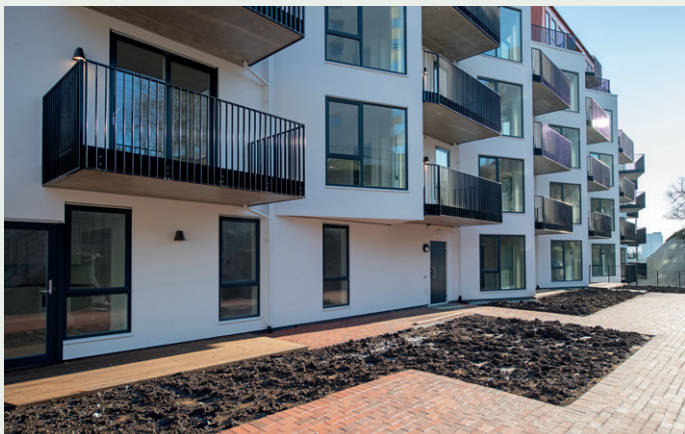
Vestvendt fasade på nybygget.
