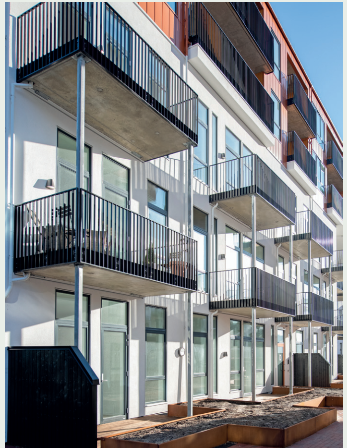
Balkonger og markterrasser på vestsiden av det rehabiliterte bygget.
