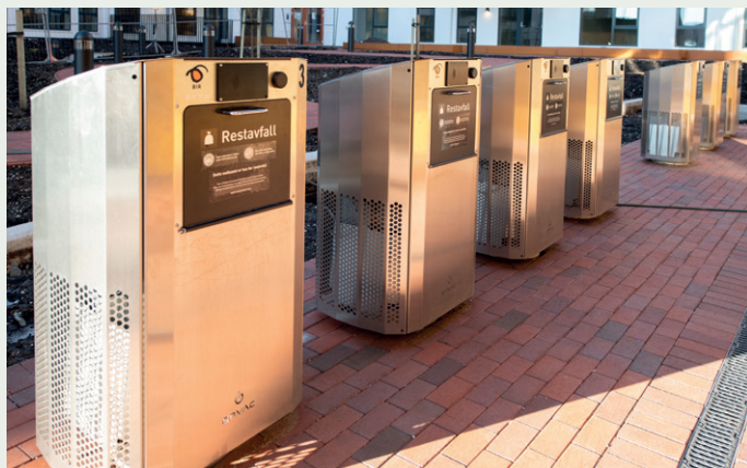
Nedkast til bossuganlegg.
