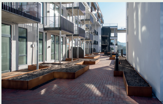
Passasje mellom det rehabiliterte bygget (til venstre) og nybygget på en nordlige delen av tomten.
