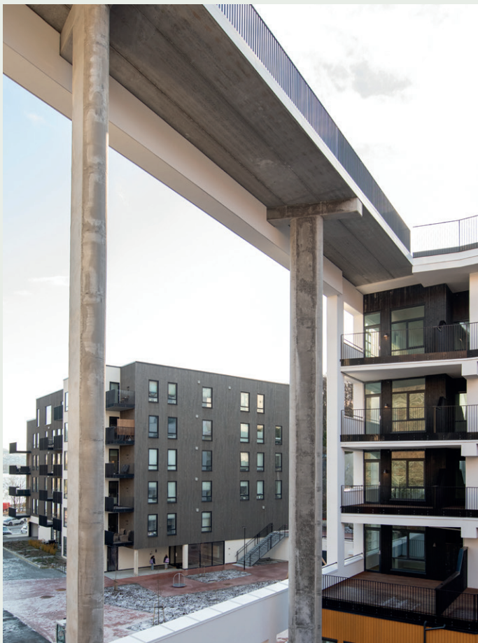
Portalen bæres av to plasstøpte søyler.
